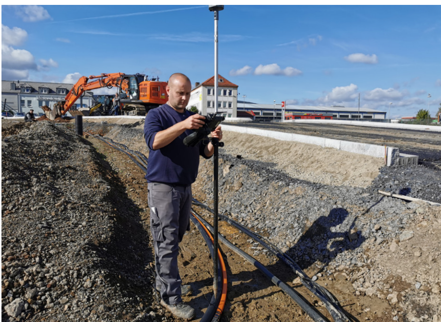
David Melle auf der Baustelle Rudolstädter Straße ■
